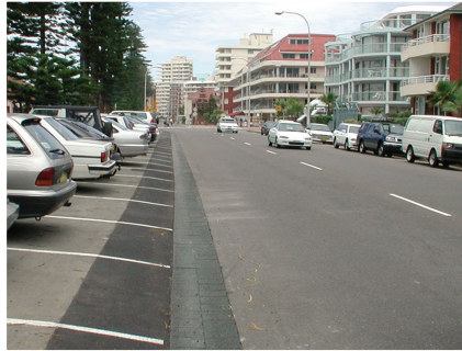
Waterdoorlatende bestrating laat het regenwater in de drainageplaten stromen.
