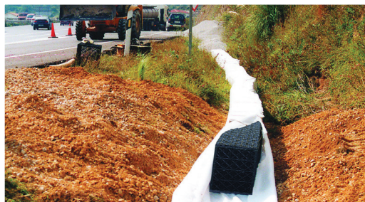
INFILTRATIE EN BUFFERING
