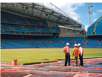
Drainageplaten houden sportvelden droog en water wordt gerecycled.
