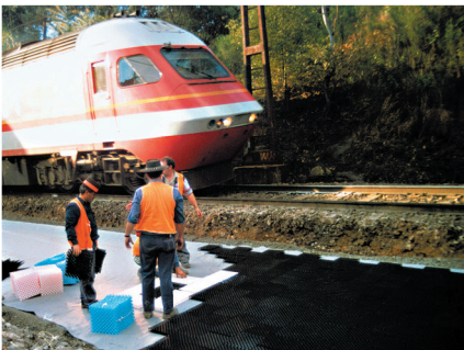
Drainageplaten maken "ontoegankelijk" gebied toegankelijk voor verkeer.
