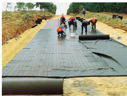
Horizontale drainageplaten voorzien in buffering en infiltratie onder de bestrating.
